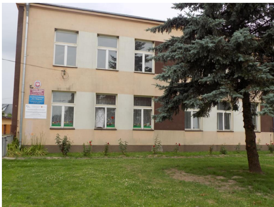
Zdjęcie 8. Budynek Niepublicznego Przedszkola „Jaś i Małgosia” w Bodzechowie
