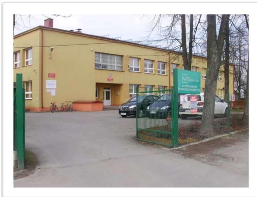
Zdjęcie 7. Budynek Publicznej Szkoły Podstawowej w Szwarszowicach
