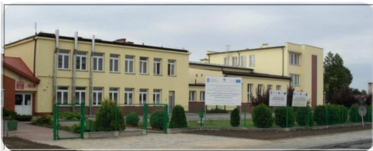
Zdjęcie 1. Budynek Zespołu Szkół Publicznych w Szewnie
