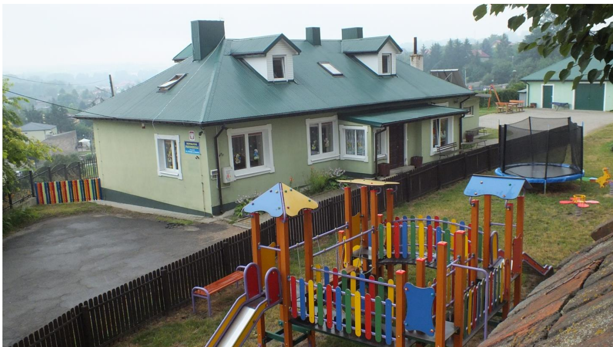
Zdjęcie 9. Budynek Niepublicznego Przedszkola przy parafii Św. Mikołaja w Szewnie.
